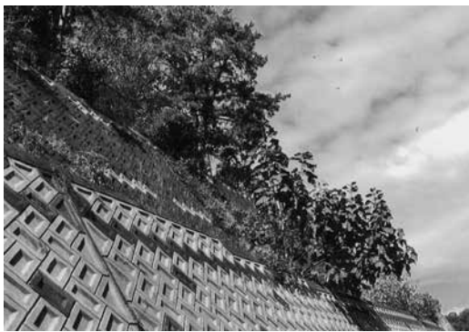
山陽団地の擁壁
