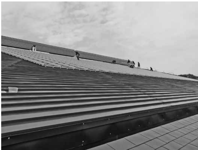
山陽ふれあい公園総合体育館屋根工事
