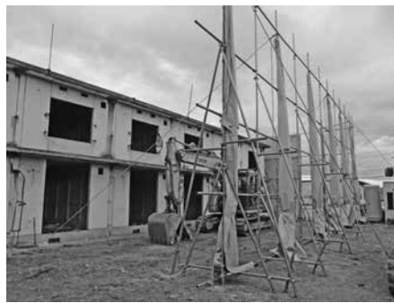
山陽団地6丁目解体工事の様子
