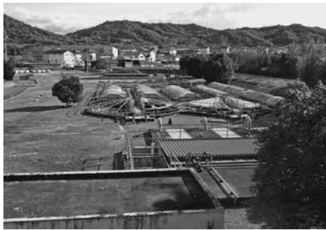
桜が丘東浄化センター
