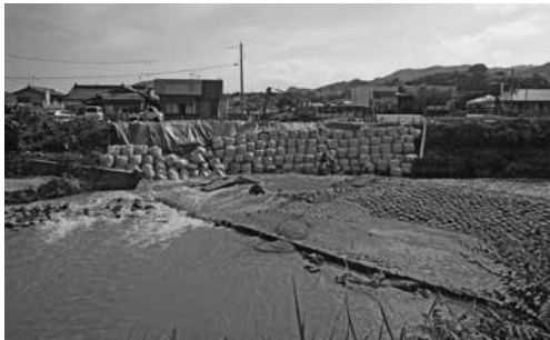
平成30年7月豪雨後の下市地内
