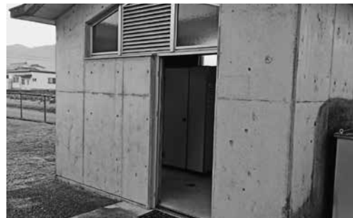
西山グラウンド外部トイレ
