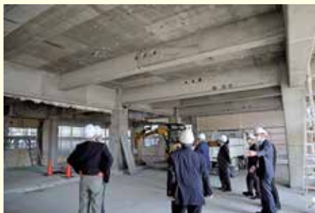
旧消防本部庁舎の視察状況
