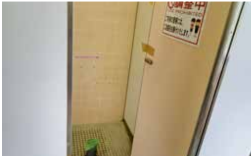
ふれあい公園体育館のトイレ洋式化改修中
