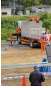
岡山県災害廃棄物仮置き場設置訓練
