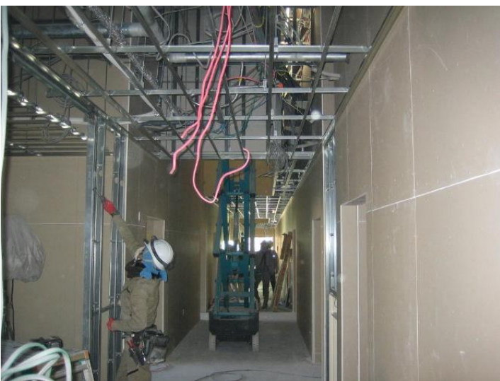
2階廊下施工状況
