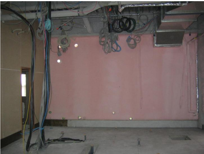
1階厨房現場発泡ウレタン吹付施工状況
