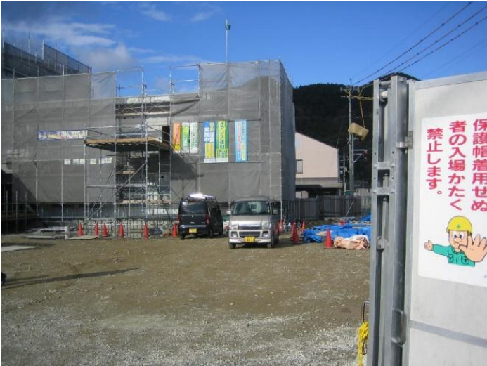
南面外部足場架設状況
