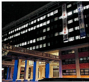
岡山県庁舎ピロティ(岡山市)
