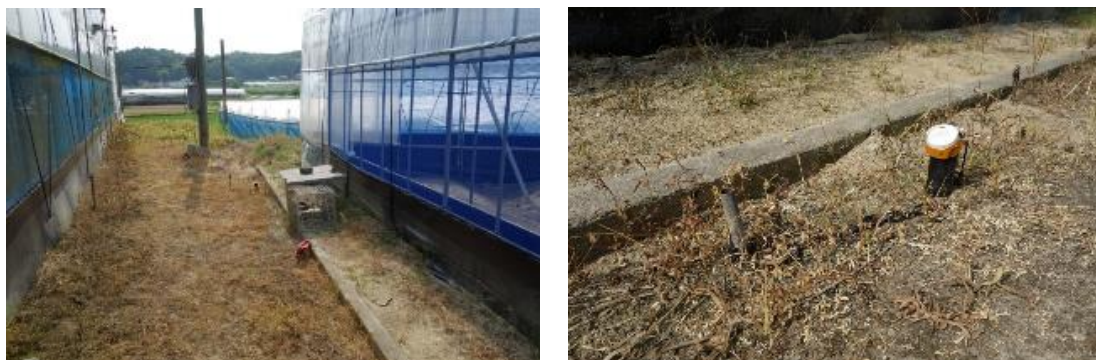
箱わなの設置状況（左）とアラホールの設置状況（右）
