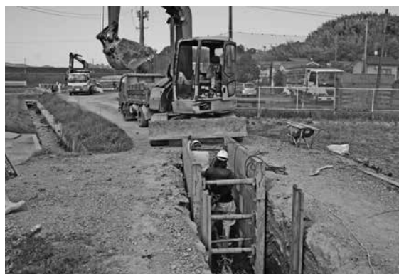
下水道工事の様子
