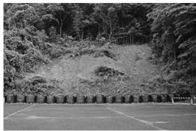
のり面の状況
