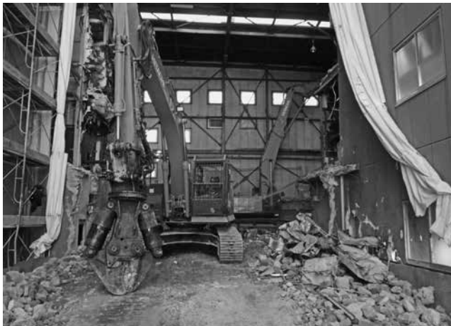
山陽桜が丘清掃センター解体工事現場
