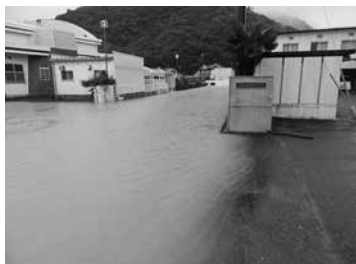
熊山支所周辺水没状況
