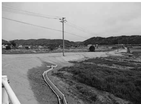
工事中の市道 岩田・長尾線
