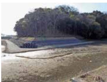
両宮山古墳墳丘裾の工事
