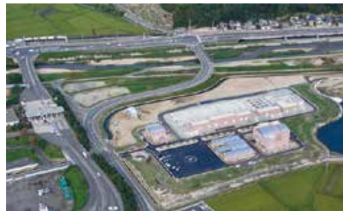
山陽浄化センター
