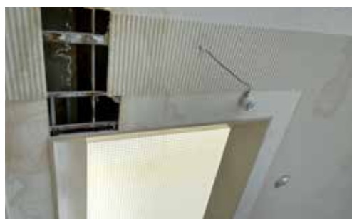
天井板を取り外している山陽北小学校
