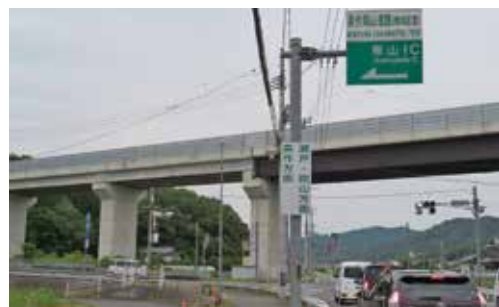
美作岡山道路熊山インターチェンジ付近
