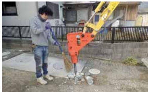
合併浄化槽工事中
