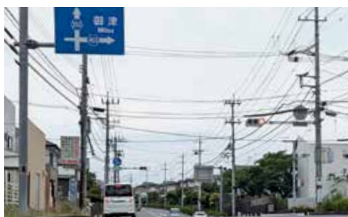
桜が丘東地内の坂で見通しの悪い交差点
