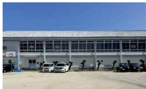
雨漏りがしている高陽中学校体育館
