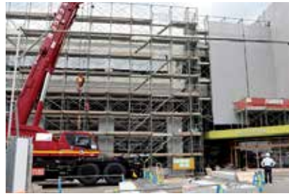
中央公民館の工事状況
