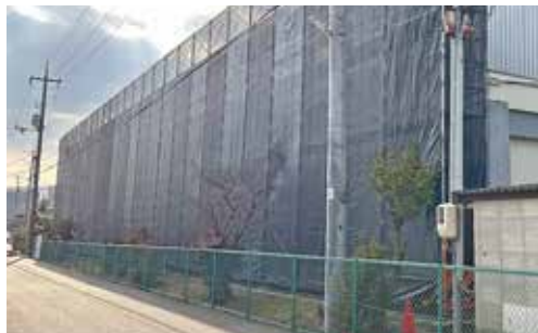
学校施設（高陽中学校）整備の工事現場
