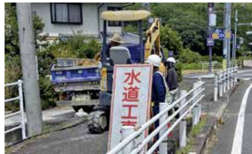
インフラ整備（水道工事中）
