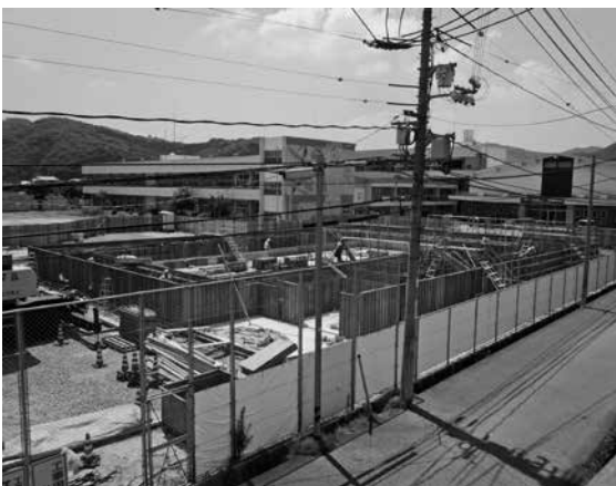
吉井中学校プール（工事中）
