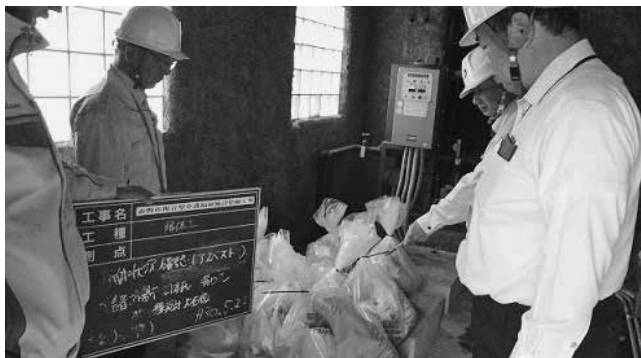
除去されたアスベストの確認の様子
