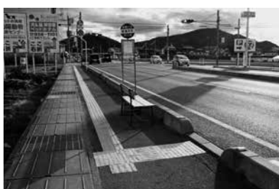
県道に設置された点字ブロック
