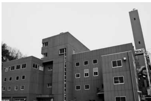
旧焼却場（多賀、中島）
