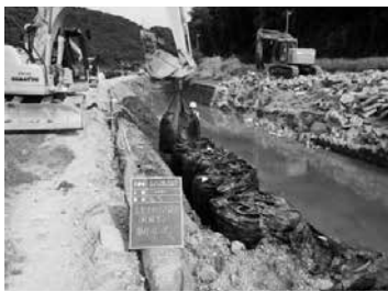
両宮川災害復旧工事
