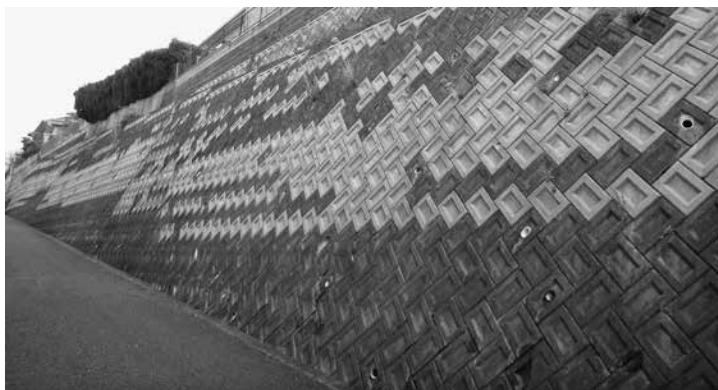
山陽団地公共擁壁
