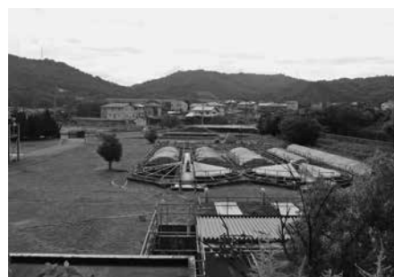
桜が丘東浄化センター
