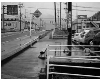
下市地内歩道未整備部分
