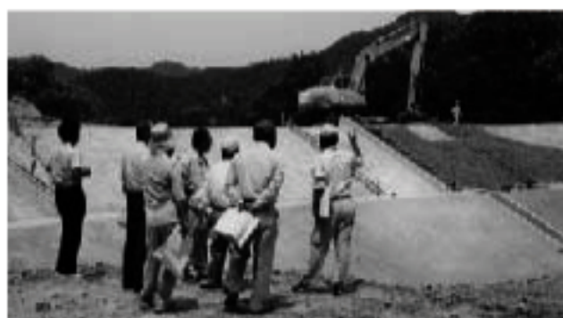
奥古原新池の災害復旧工事現場
