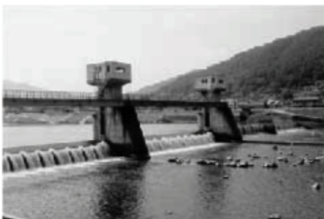
吉井河原屋井堰
