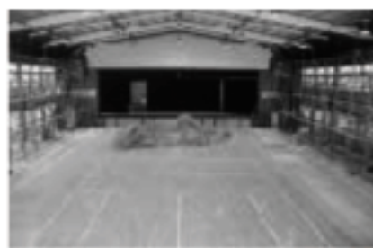
耐震工事中の山陽西小学校体育館(山陽)
