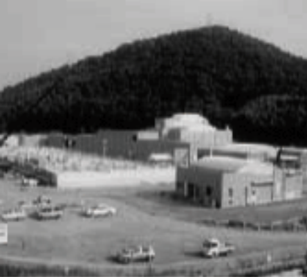
建設が進む山陽浄化センター(立川)
