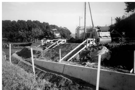
改良工事が進む市道宗慶線（下仁保）
