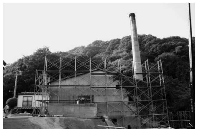
焼却施設解体工事（鴨前）
