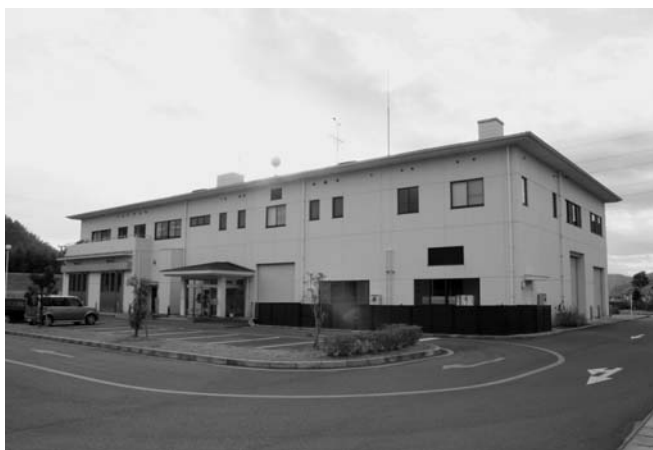
和気赤磐衛生センター（し尿処理施設）
