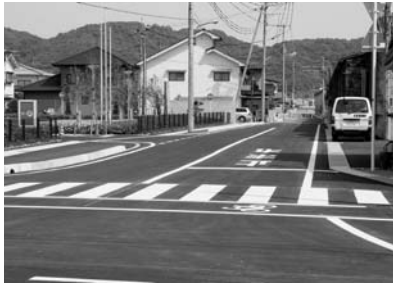
工事の進む桃光園線
