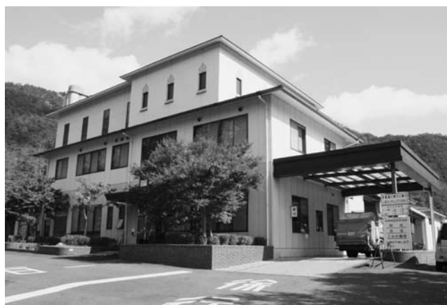
耐用年限がせまる和気北部衛生施設組合クリーンセンター
