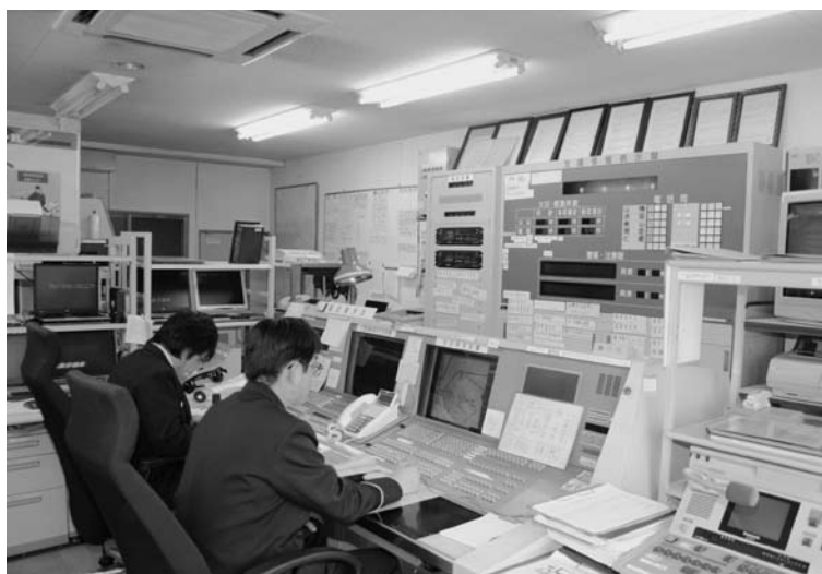
消防本部の通信指令室
