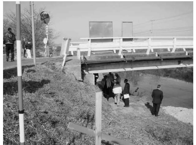
委員による現場視察（立川橋）
