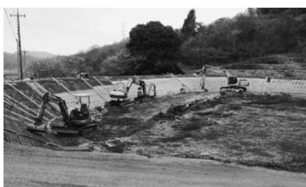
改修中のため池
