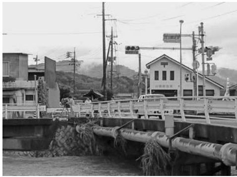
交差点改良予定の正崎橋周辺
