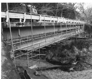
橋の長寿命化工事
