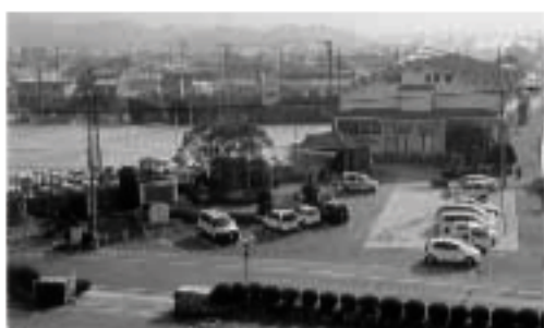
中央図書館建設予定地（下市）
