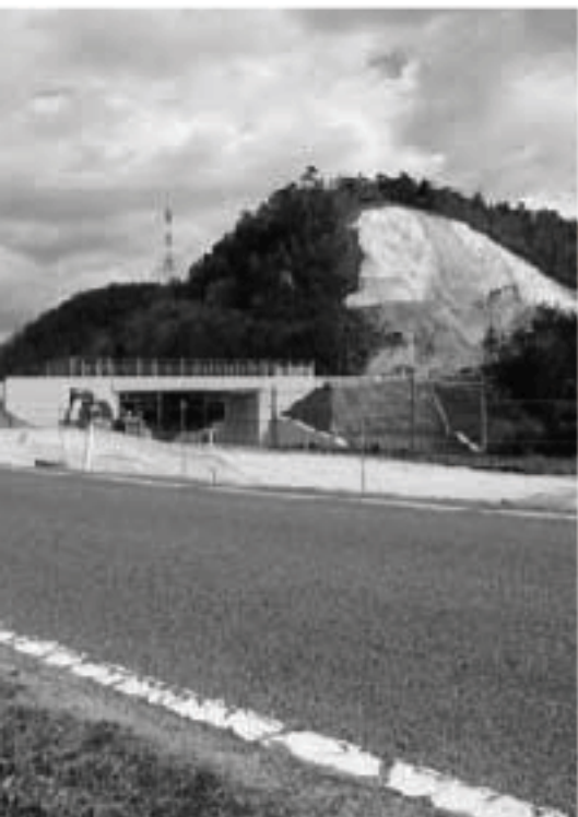
市道千鉢奥吉原線工事現場（千鉢池内）
