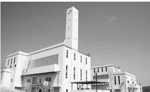
エコプラザあかいわ（焼却施設）
