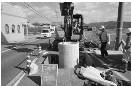
下水道工事の様子
