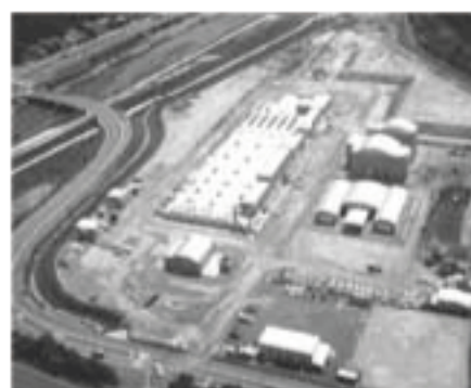
山陽浄化センター（立川）
