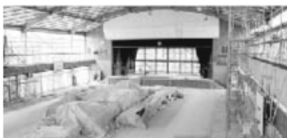
耐震補強工事（山崎小）
