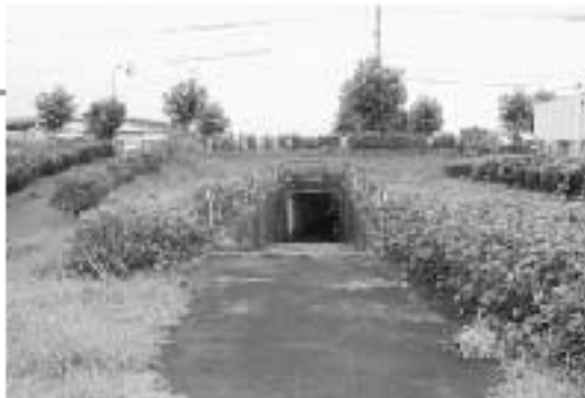
地下道付近探検後の掘削（桜が丘地内）
