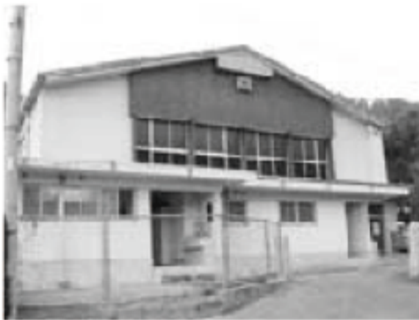
赤坂中学校屋内運動場
