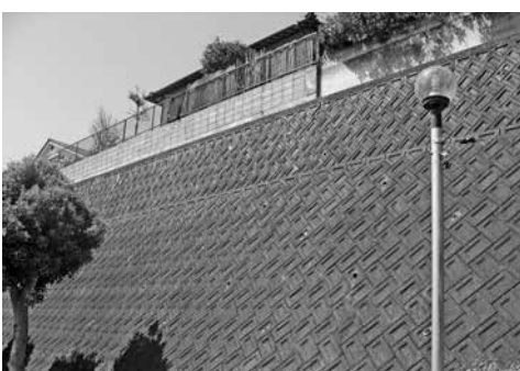
山陽団地内の調査中の擁壁
