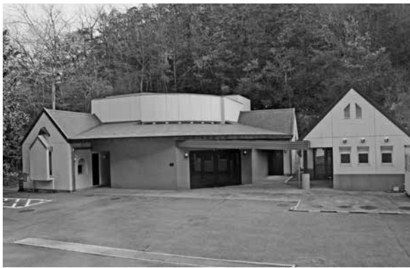
和気北部衛生施設組合火葬場
