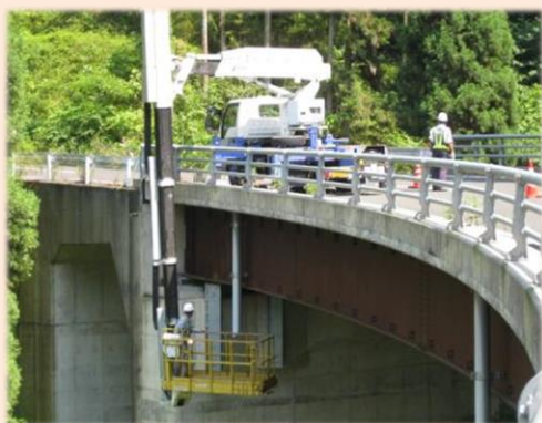
橋梁点検車による点検
