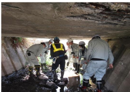
橋梁点検実習状況
