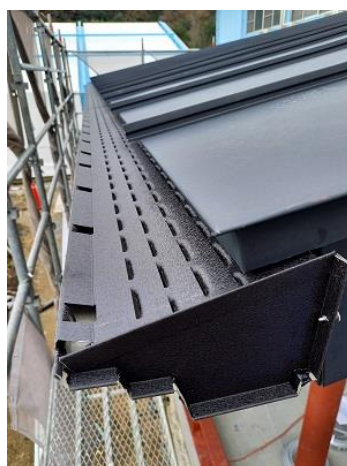
写真8 同左屋根軒樋
