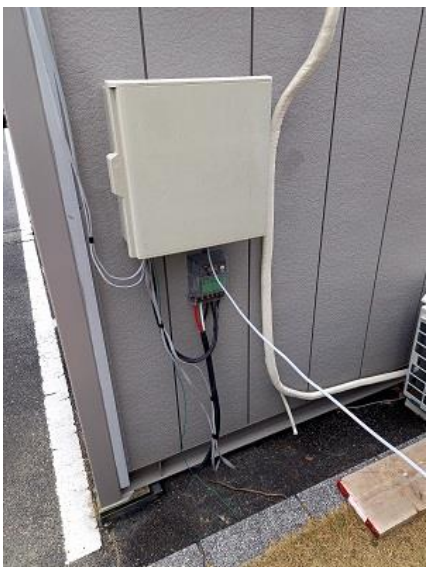
写真12 仮設電気引き込み
