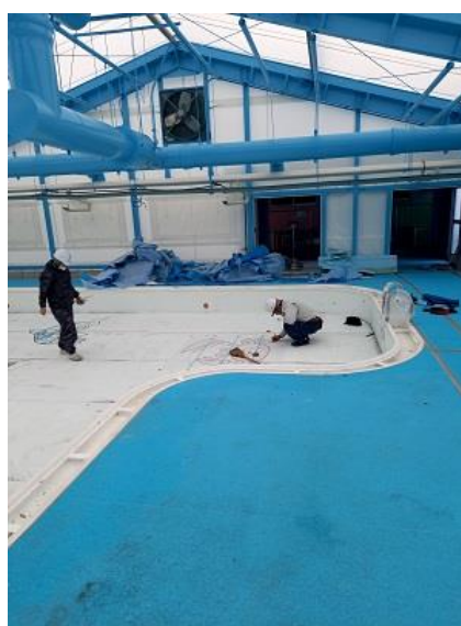
写真11 小プール塗装下地
