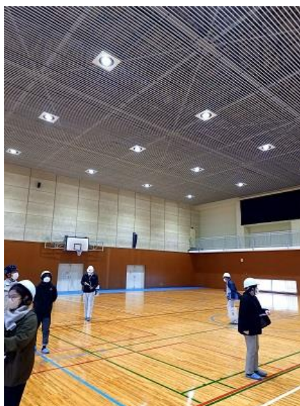
写真4 体育館天井照明機器 LED 化
