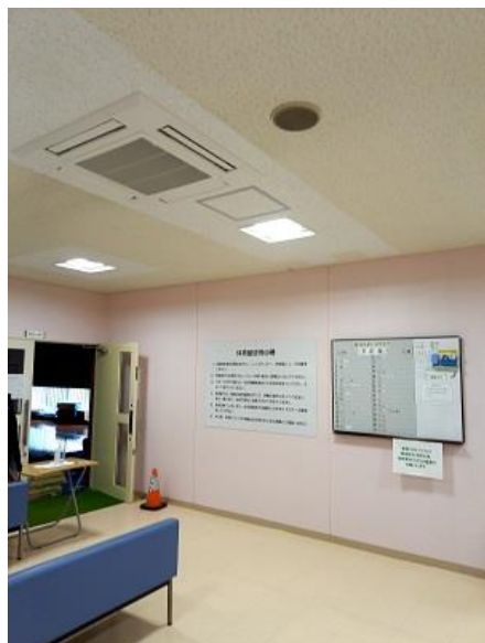
写真3 ロビー天井改修完了
