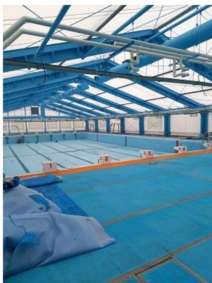
写真10 プール棟内部
