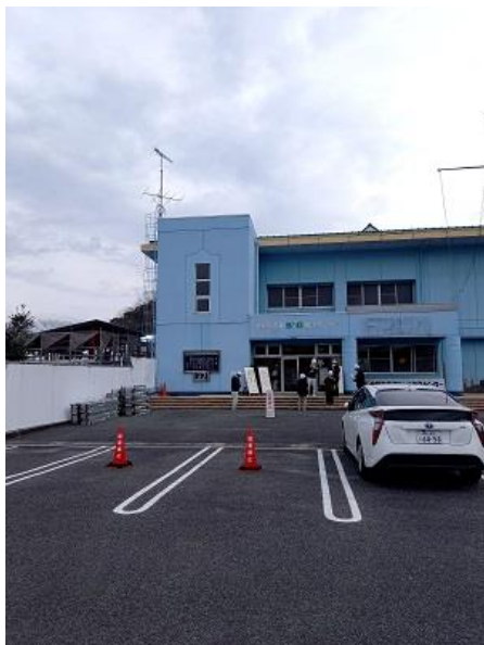
写真1 体育館棟正面
