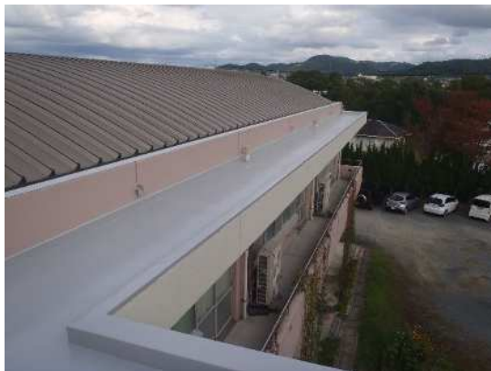
屋上 北館 東棟南庇 塗膜防水 現況
