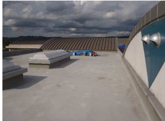
屋上 南館 防水下地 現況
