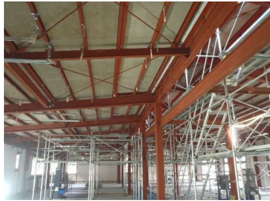
内部 仕上げ工事前 現況
