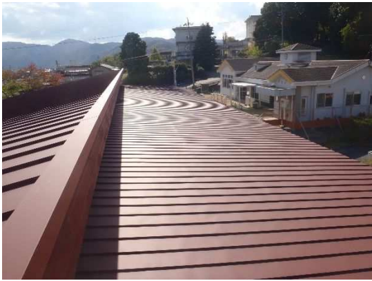
屋根 長尺金属板葺き 現況
