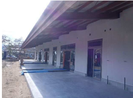
外部 南面 現況
