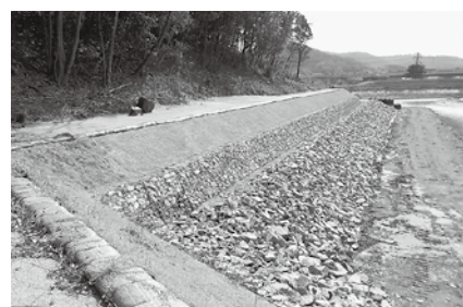
昨年度の工事状況(前方部側面)
