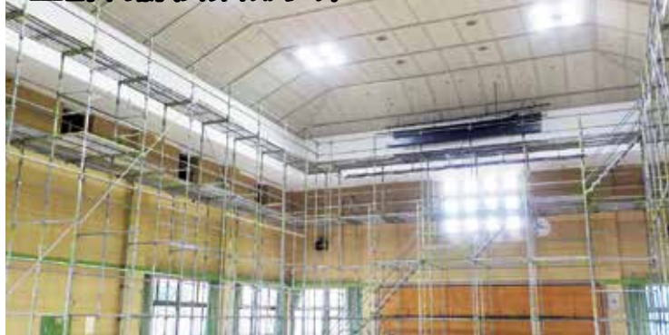
LED工事の様子(フィットネスアリーナ)
