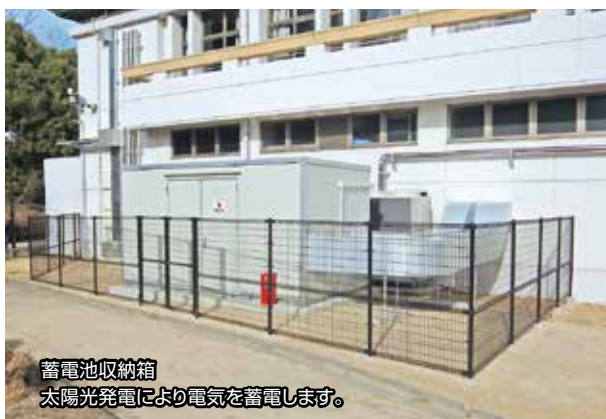
LPガスバルクタンク 停電時でもガスなので、空調設備が稼働できます。
