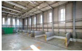
リサイクル施設内で資源化物を分別保管
