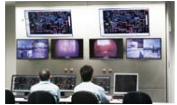
焼却炉内の温度や有害物質濃度を常に監視する中央制御室
