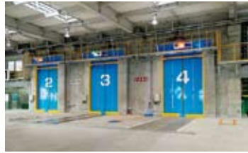
焼却施設内には収集車からごみを投入する大きな扉が3枚
