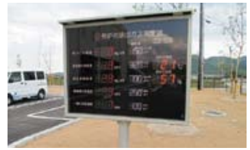
排出ガス中の物質の濃度を表示する電光表示板
