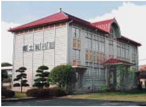
▶ 吉井支所の隣にある資料館の外観
