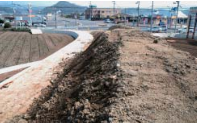
順調に工事が進む五日市西中線
