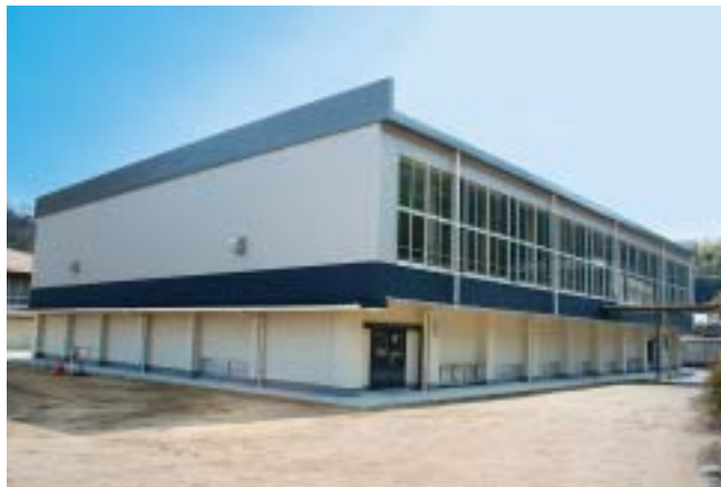
完成したばかりの赤坂中学校体育館
